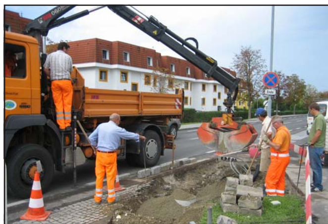
Die Straßenmeisterei arbeitet für die Schutzweg-Errichtung
